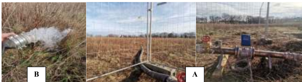
Vannes du forage (A) et le rejet de l'eau (B)
